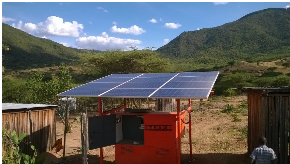
Figura 21: Projecto da PowerGen no condado de Samburu, no Quénia, exibindo uma micro-rede de 3kW
